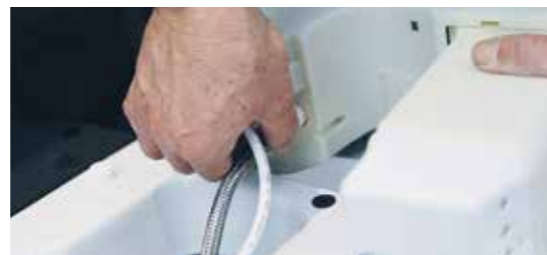
De aansluitingen voor elektriciteit en water zijn onzichtbaar in de keramische wc-pot weggewerkt.
