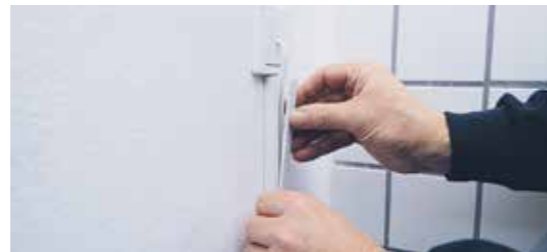
De douche-wc kan zonder moeite via een externe aansluiting van elektriciteit worden voorzien.
