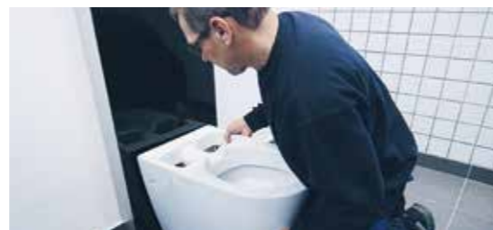
De Geberit AquaClean Sela keramische pot wordt aan de Monolith sanitairmodule bevestigd, zodat alles precies past.
