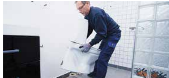
De oude staande keramische pot wordt verwijderd.
