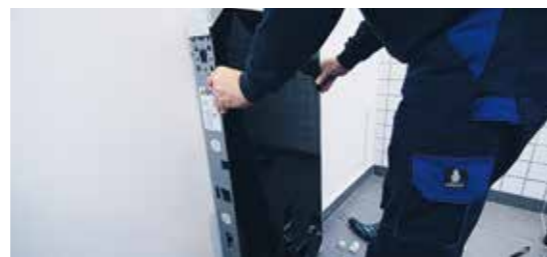
De Geberit Monolith sanitairmodule wordt aan de muur gemonteerd.
