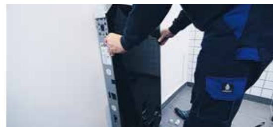
Le module sanitaire Geberit Monolith est ensuite fixé sur le mur.
