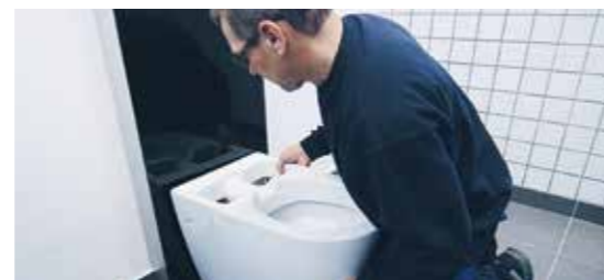
L'appareil Geberit AquaClean Sela est monté sur le module sanitaire Monolith et s'y adapte parfaitement.
