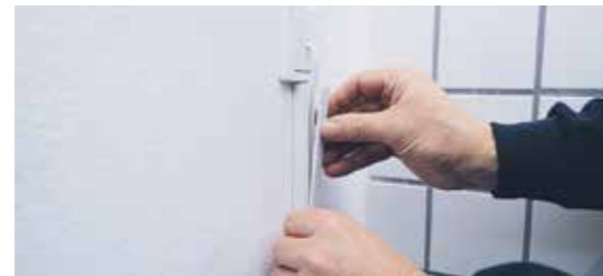
Le branchement électrique pour le WC-douche est apparent et se monte facilement.
